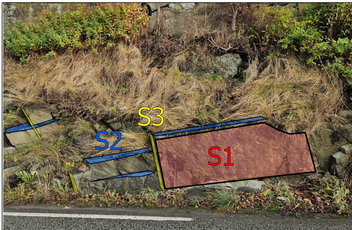
Figur 3: Bilde av bergskjeringa under Freimsvegen 1. Sprekkesetta er markert og namngjevne.
